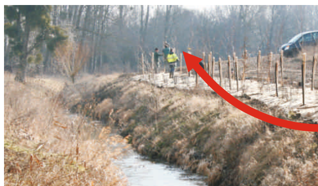
Pilotage d'un chantier de plantation
